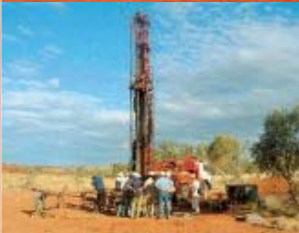
ビルバラでの掘削調査の様子
